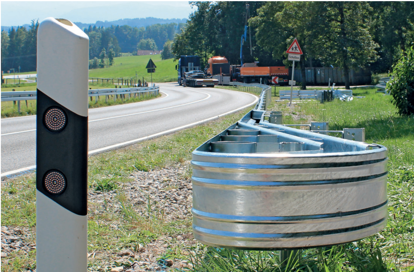
» Abb. 5 Nachrüstung von Fahrzeug-Rück- haltesystemen an Landstraßen im Rahmen des Ver- kehrssicherheits- programms 2020 „Bayern mobil – sicher ans Ziel“
